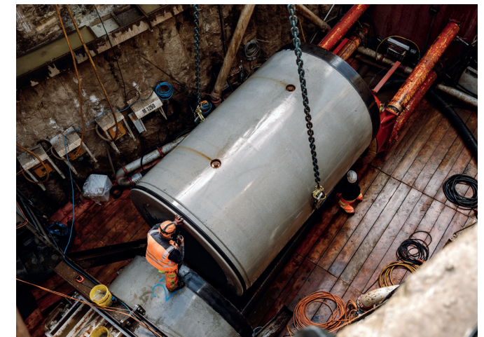
Baustelle für die Verlängerung des Entlastungssammlers Wupper in Wuppertal-Barmen.
