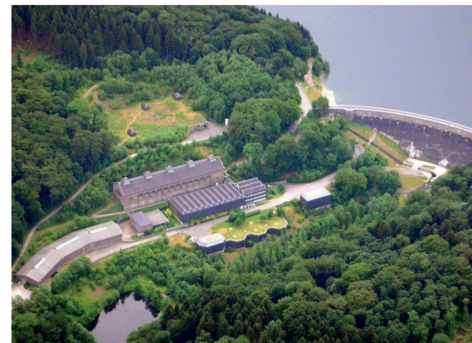
Das Wasserwerk Herbringhausen bereitet rund 9 Mio. m 3 Trinkwasser pro Jahr auf.
