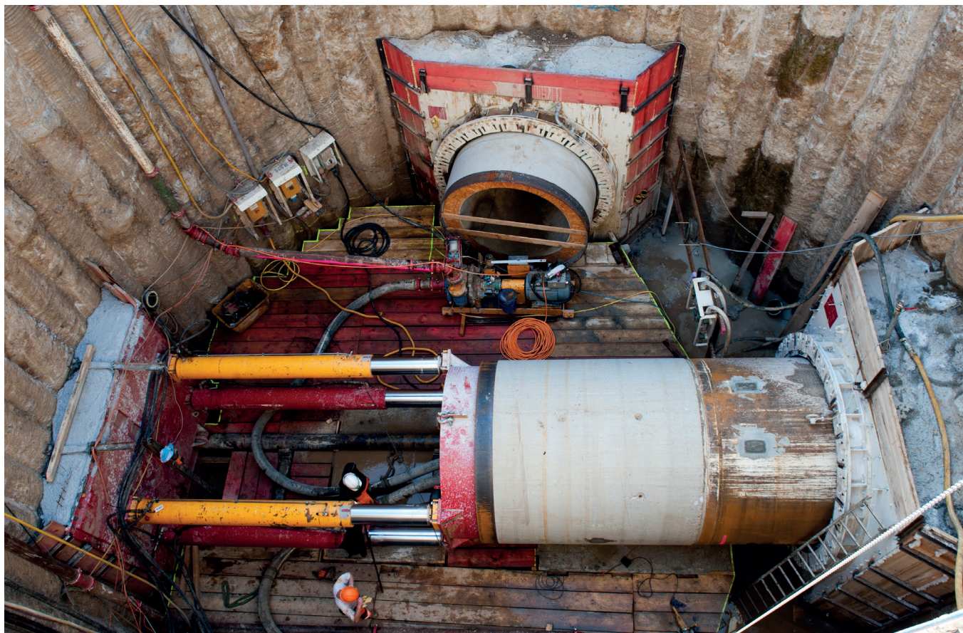
Der „Düker“ (hier ein Blick in die Baustelle) in Sonnborn leitet das Schmutz- und Regenwasser aus dem Einzugsgebiet Lüntenbeck, Rottscheider Bach, Stackenberger Siefen und Eugen-Langen-Straße zum Klärwerk Buchenhofen ab.
