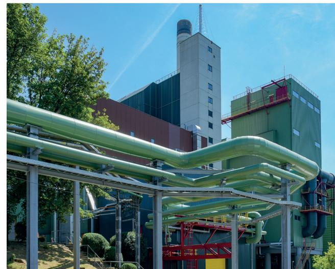
*Im Müllheizkraftwerk der AWG wird bei der thermischen Abfallbehandlung Strom und Fernwärme erzeugt. Der Strom wird auch für die Elektrolyse genutzt.*
